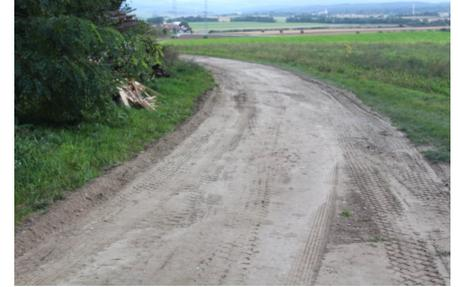
Der abgefräste Asphalt wurde im Zuge der Erhaltungsmaßnahme gleich auf den Güterwegen aufgebracht, geädert und eingewalzt. So konnte auch der Weg von der
